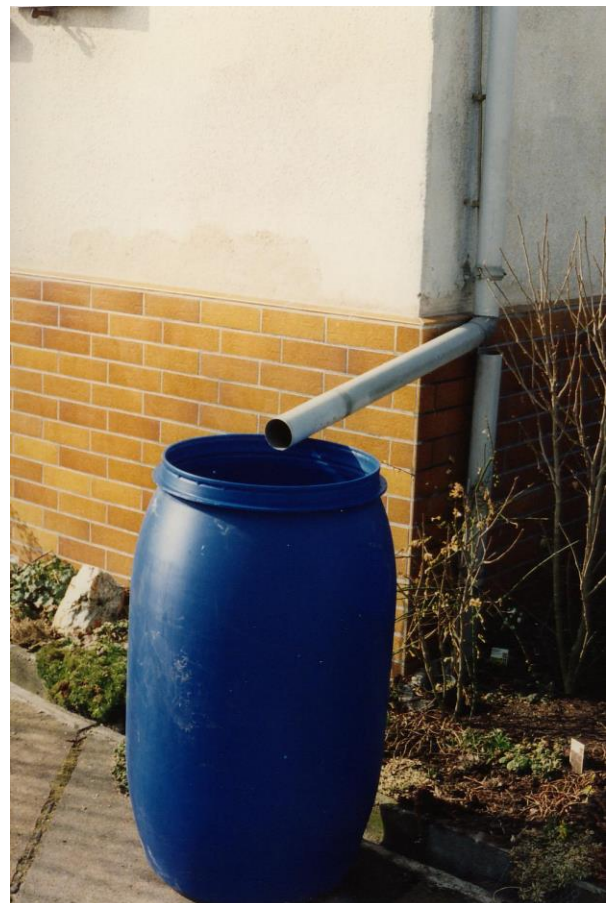
Dachrinnen werden getrennt, Regenwasser aufgefangen
