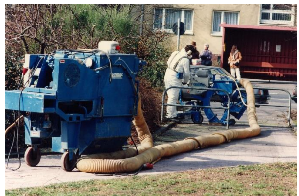
Straßen werden abgefräst, Fußwege abgeschliffen
